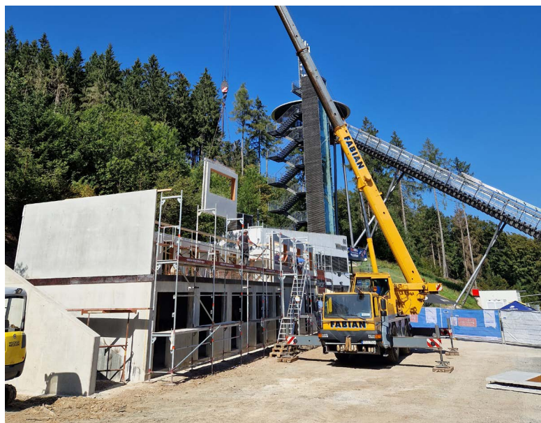
Bau des neuen Teamgebäudes
