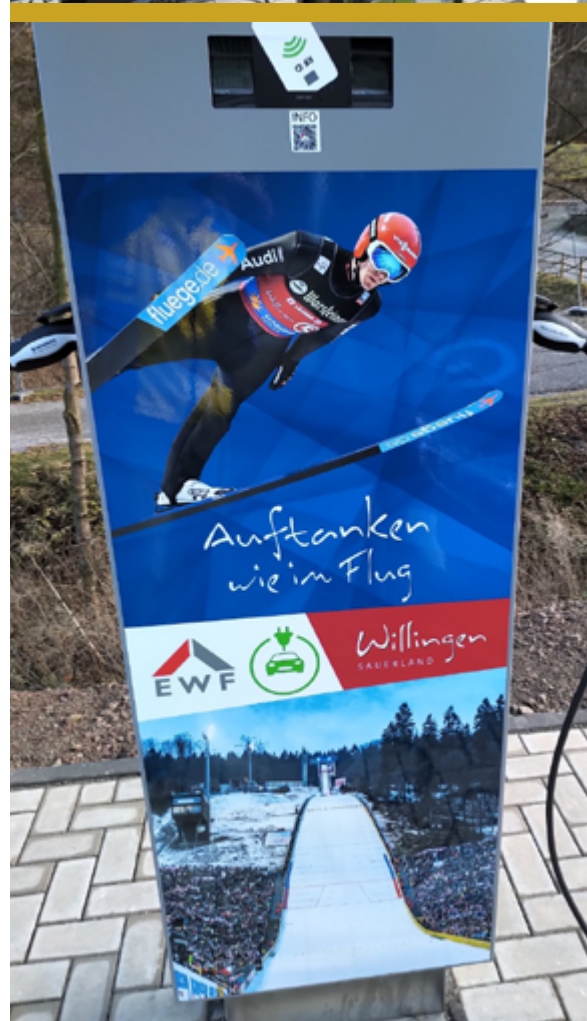
Neue E-Ladesäule an der Mühlenkopfschanze
